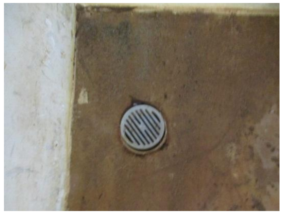
รูปที่ 2-38 ท่อรวบรวมน้ำเสียในห้องพัสดุฝอยรวม
