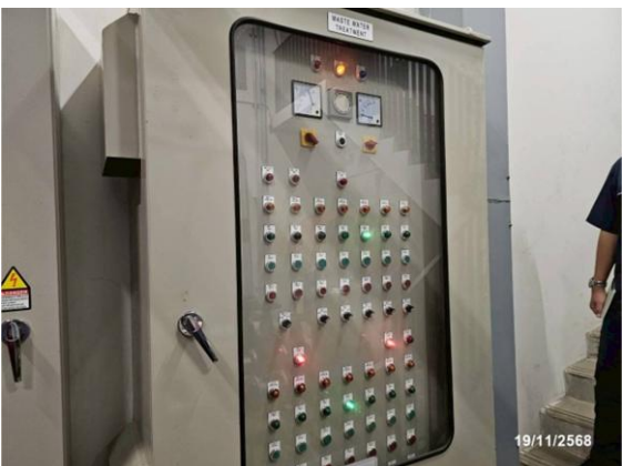
รูปที่ 2-16 ระบบมิเตอร์ไฟฟ้าสำหรับระบบบำบัดน้ำเสีย ของโครงการ
