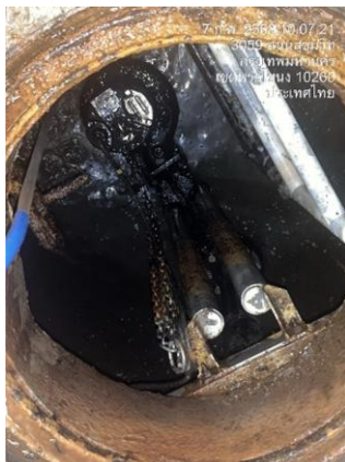
รูปที่ 2-33 เครื่องสูบน้ำในบ่อหนองน้ำ
