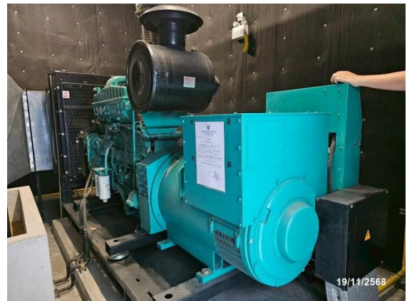
รูปที่ 2-40 เครื่องกำเนิดไฟฟ้า 300KVA
