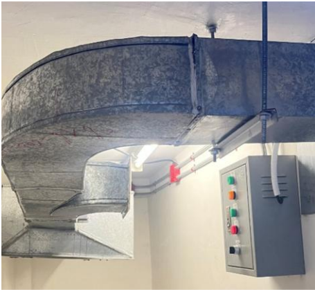
รูปที่ 2-15 ระบบระบายอากาศภายในห้องพักมูลฝอย
